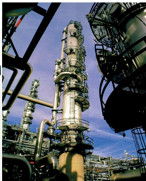
Σχήμα 5.11: Συσσκευή απλής και κλασματικής απόσταξης και κλασματική απόσταξη αργού πετρελαίου.
